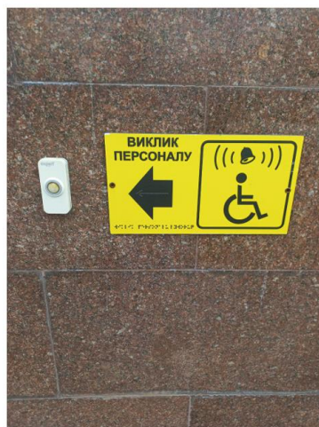
Фото № 5,6. Кнопка виклику персоналу з головного фасаду будівлі. Тактильна табличка для осіб з інвалідністю, осіб з порушенням зору з рельєфно-крапковим шрифтом Брайля з написом «Виклик персоналу»
