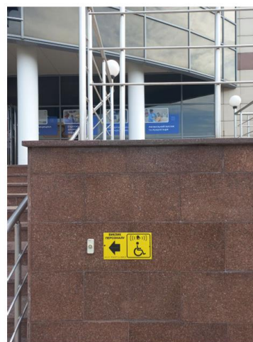
Фото № 5,6. Кнопка виклику персоналу з головного фасаду будівлі. Тактильна табличка для осіб з інвалідністю, осіб з порушенням зору з рельєфно-крапковим шрифтом Брайля з написом «Виклик персоналу»
